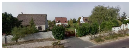
Logements pavillonnaires-rue de Mandres
